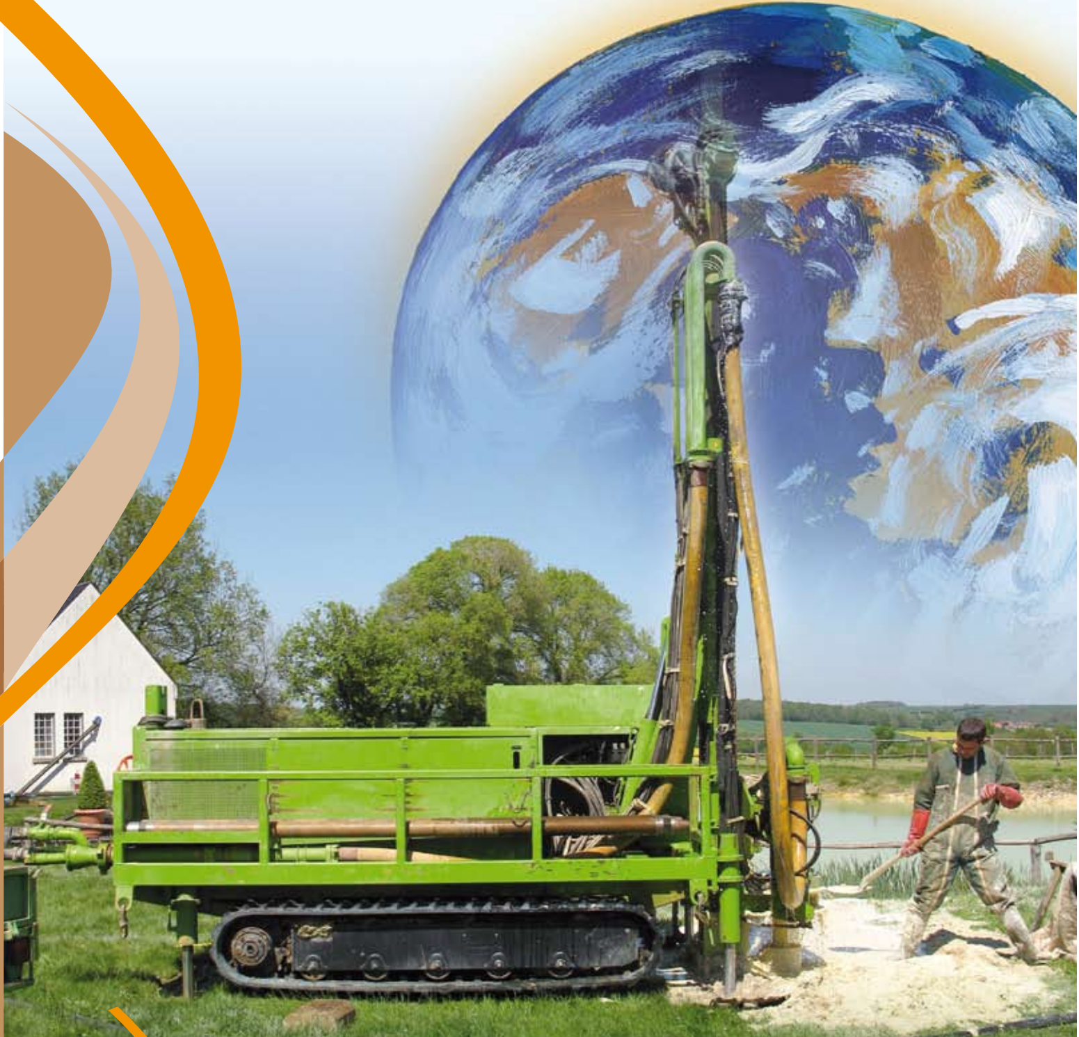
Le forage géothermique de qualité en région Centre
